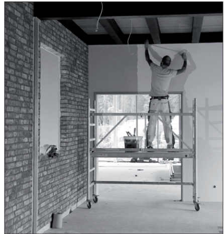
Noch wird im neuen Gemeindehaus gearbeitet, aber die Fertigstellung naht.
