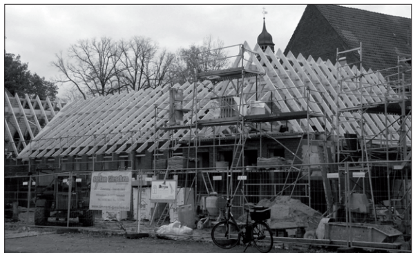
Unser neues Gemeindehaus im Rohbau am Reformationstag 2020.
